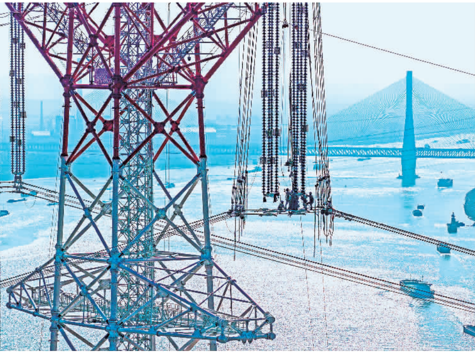
近日,在安徽省芜湖市繁昌区荻港镇长江边,安徽送变电工程有限公司施工人员正在开展甘肃—浙江±800千伏特高压直流长江大跨越南塔高空施工作业。甘肃—浙江±800千伏特高压直流工程起于甘肃武威,止于浙江绍兴,线路全长2370公里,投运后每年可向浙江输送清洁电量超360亿千瓦时。
