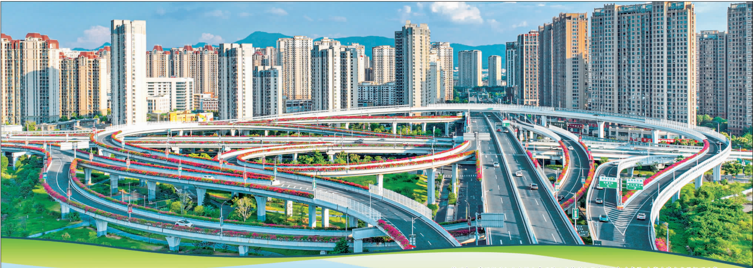
赣州中心城区新世纪立交桥上盛开的三角梅花与往来车流相映成景,勾勒出城市发展靓丽画卷
