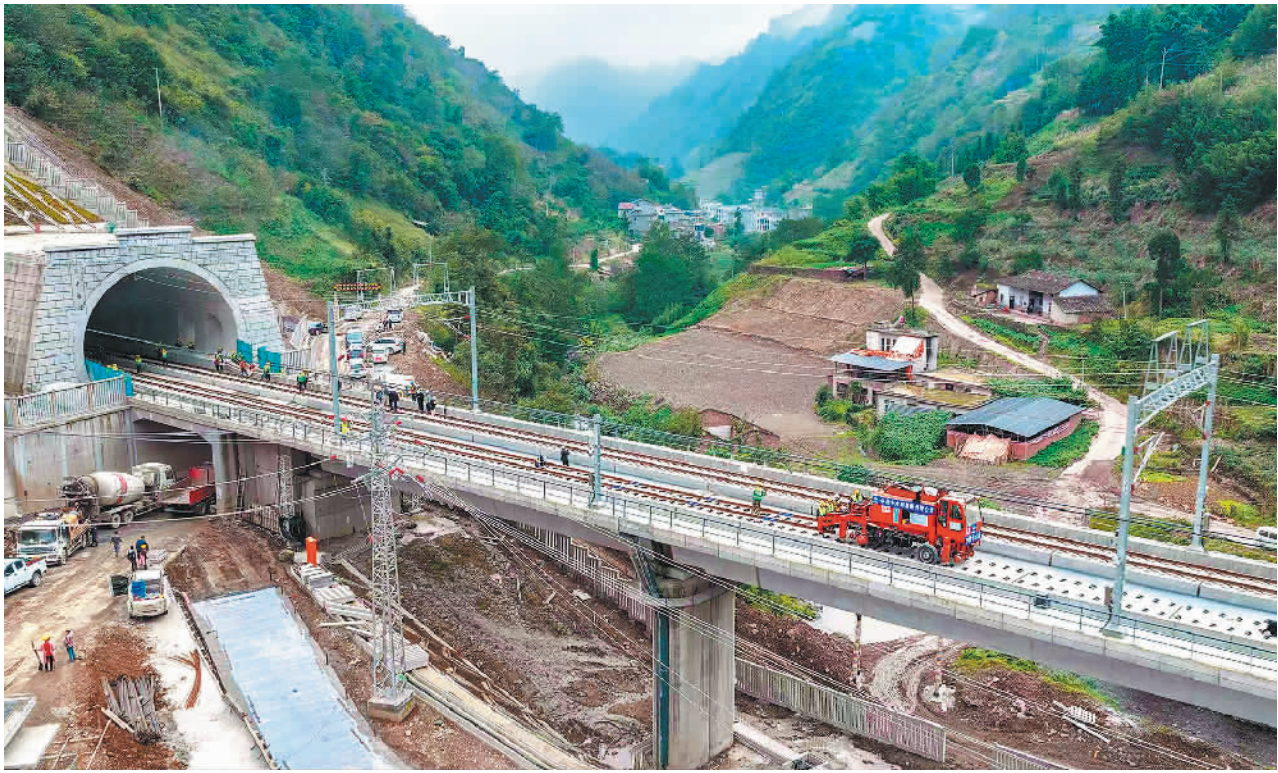
10月24日，渝昆高铁全线铺轨完成，实现轨道贯通。渝昆高铁全线建成通车后，昆明至重庆的行车时间将压缩至2.5个小时左右，昆明至成都的行车时间也将压缩至3个小时以内。图为渝昆高铁筠连隧道口施工现场。 陈 畅摄(中经视觉)
