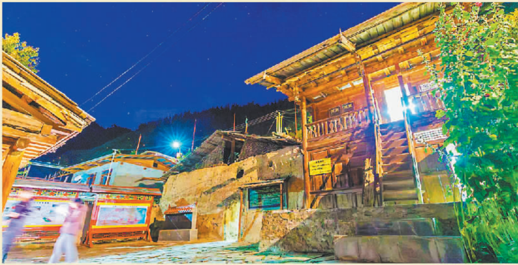
▲10月13日拍摄的位于甘南州迭部县达拉乡高吉村的俄界会议旧址。 本报记者 刘月杨摄
