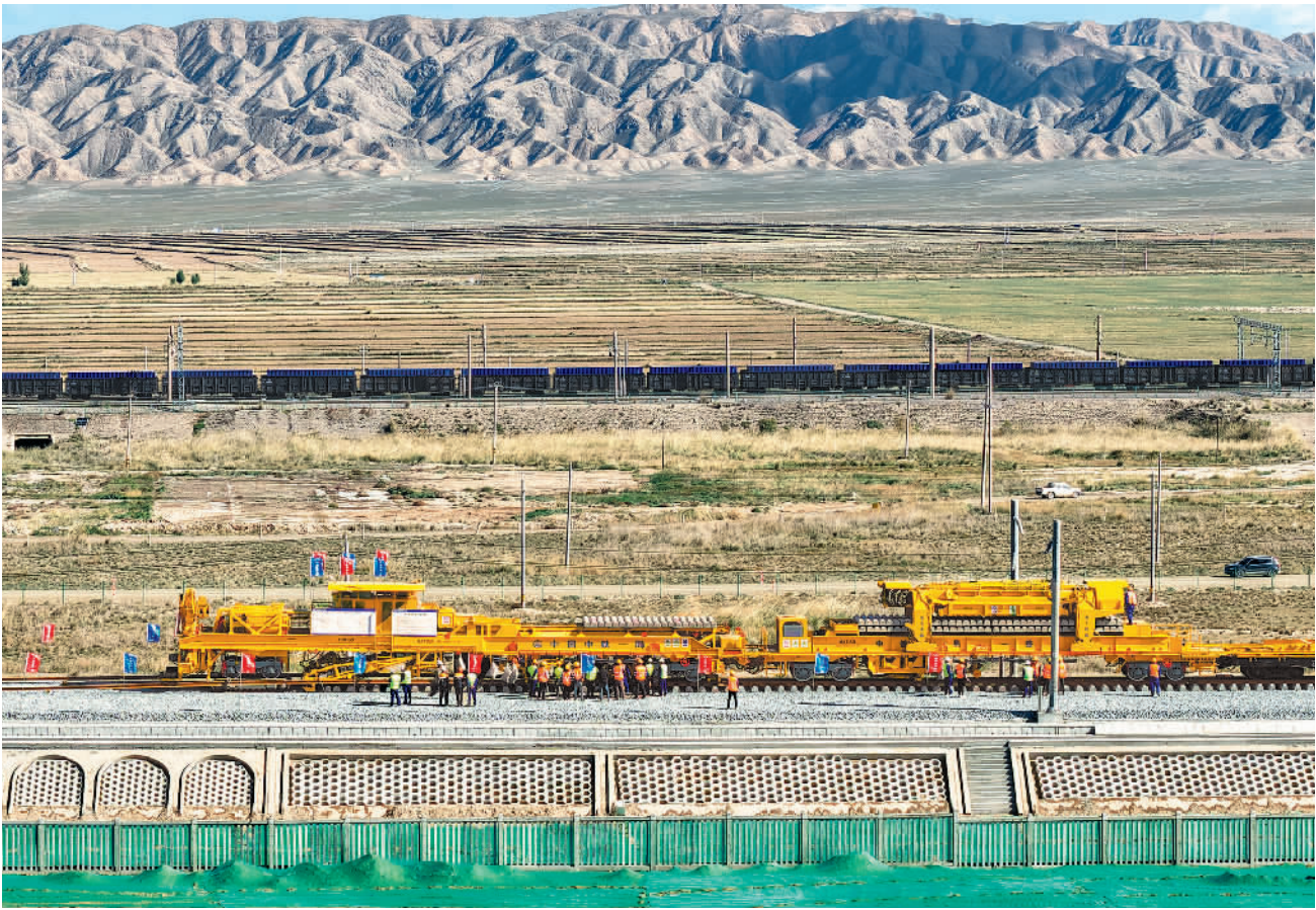
10月9日，兰张高铁武威至张掖段全面进入铺轨阶段。兰张高铁是国家“八纵八横”高速铁路网陆桥通道和丝绸之路经济带快速客运通道的重要组成部分，目前正在建的武威至张掖段正线全长244.05公里，2027年底具备开通运营条件。图为中铁一局施工人员操作长钢轨铺设机组进行铺轨。解广义摄(中经视觉)
