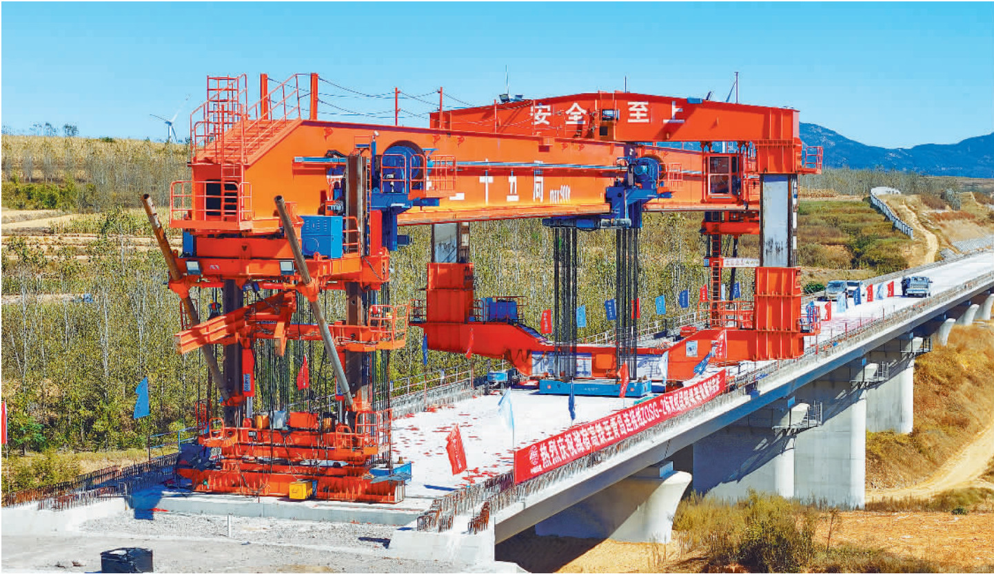
10月7日,潍宿高铁至青岛连接线全线无砟轨道箱梁架设任务圆满收官,项目正式转入无砟轨道施工关键阶段。据介绍,潍宿高铁至青岛连接线位于山东半岛南部,线路全长108.78公里。 张进刚摄 (中经视觉)
