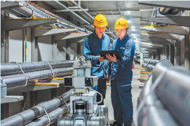
南方电网深圳供电局输电管理所人员与机器狗协同巡视地下电缆隧道
