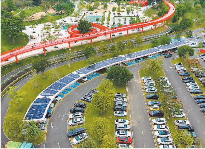
南方电网深圳光明虹桥公园闪充示范站单次最大充电功率可达4.21兆瓦
