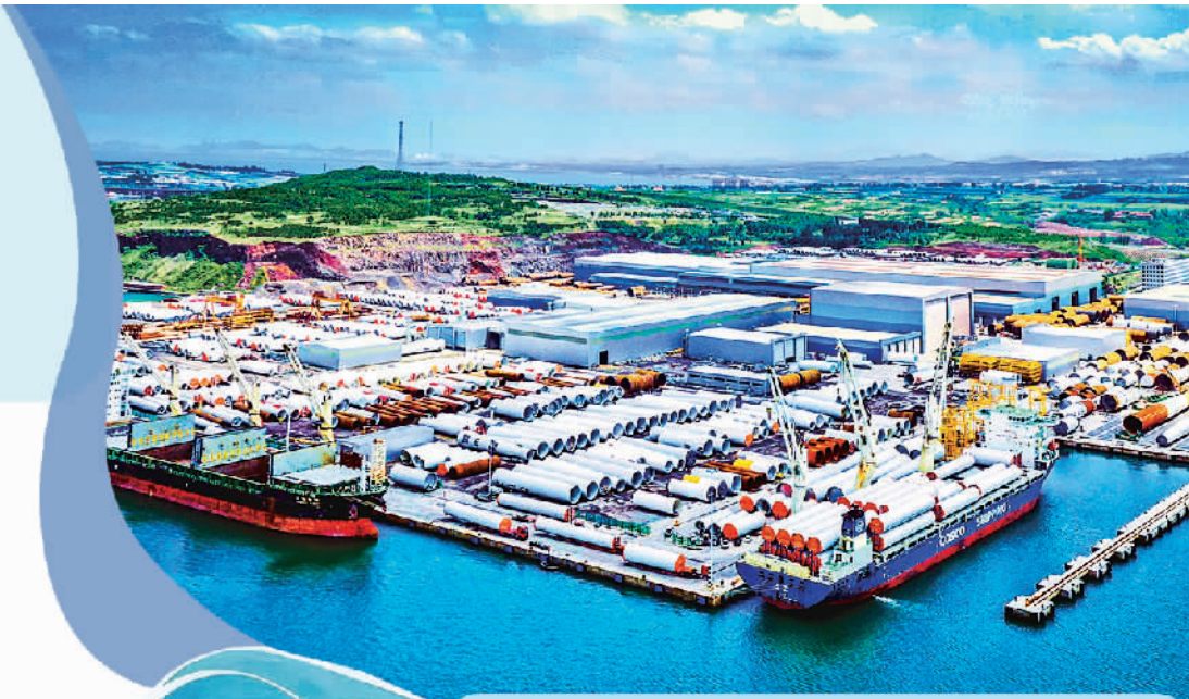
位于山东省烟台市的蓬莱大金海洋重工有限公司生产基地。(资料图片)
