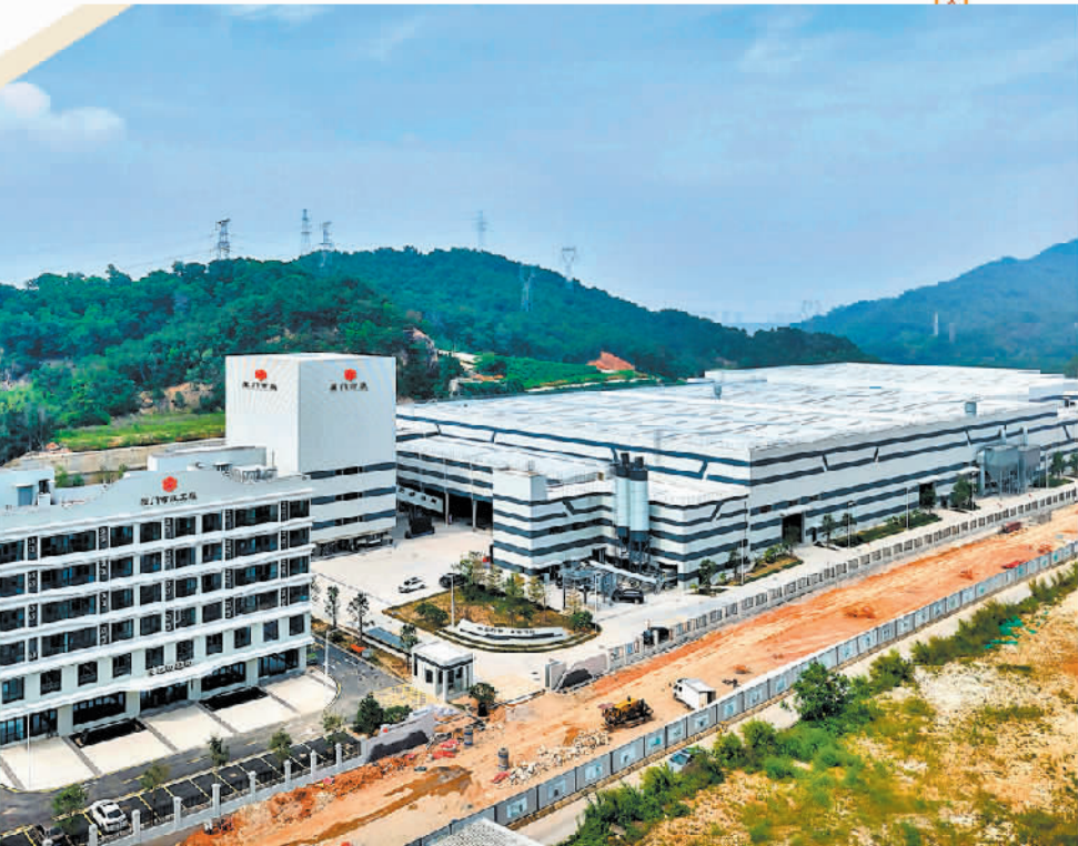
福建厦门建成大型建筑垃圾综合处置基地,推动固废循环利用。 吴 懿摄(中经视觉)
