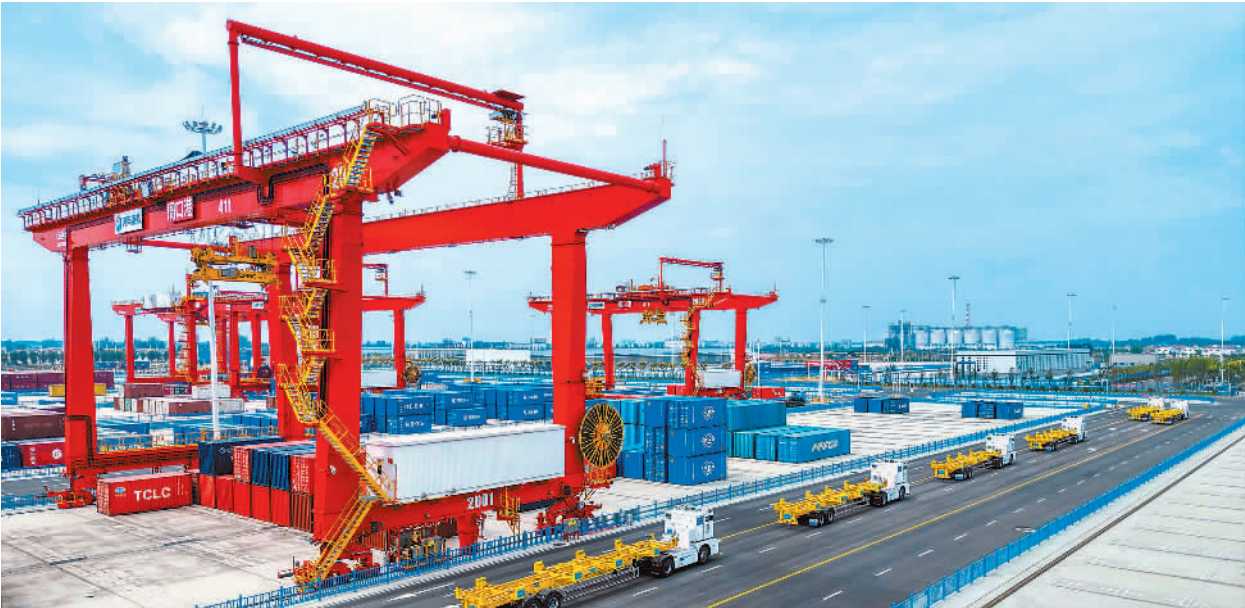
9月13日，河南省周口市周口港中心港区小集作业区，码头门机与货运车辆协同联动，实现水运与陆路运输无缝衔接。周口港是河南省规模最大的内河港口，承担豫东南区域大宗货物集散、集装箱转运功能。张展硕摄(中经视觉)
