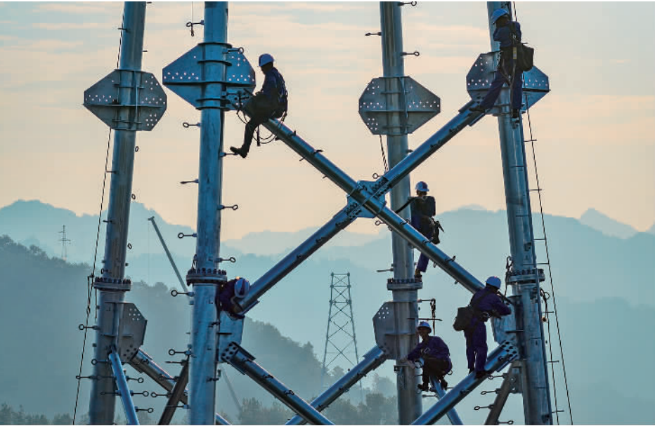
9月7日,在湖北宜昌夷陵区邓家湾,国网湖北超高压公司工作人员开展三峡水运新通道线路改造作业。线路迁改完成后,将有力保障新航道顺利开挖。陈 军摄
