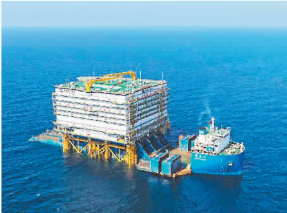
绿电枢纽就位，深远海动脉成型，三山岛工程将为粤港澳大湾区构建起一条稳定高效的深远海绿电专属输送通道
