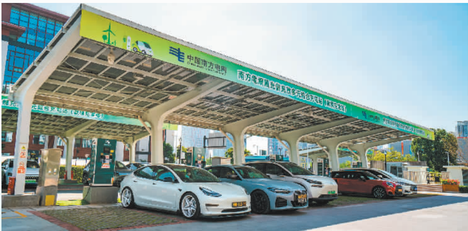
2025 年，南方电网广东珠海横琴供电局建设“点面结合、全域覆盖”的充电网络，有力支持“澳车北上”“港车北上”。图为横琴供电局建设的风光储充放多元综合欧标充电站
