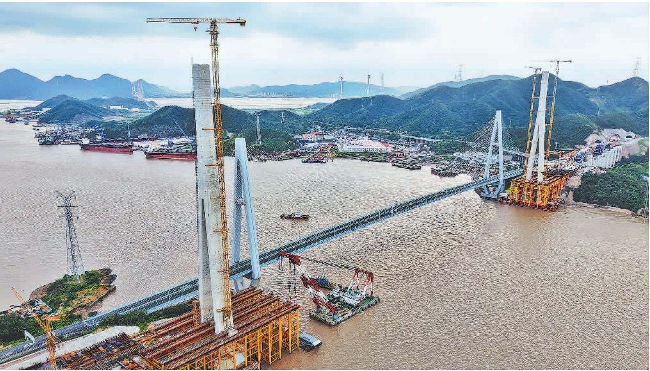
9月8日，甬舟铁路桃天门公铁两用大桥首节钢箱梁架设完成，标志着甬舟铁路三座跨海桥梁全面进入梁架建设新阶段。桃天门公铁两用大桥是连接浙江舟山群岛册子岛和富翅岛的重要跨海通道。新华社记者 黄宗治摄
