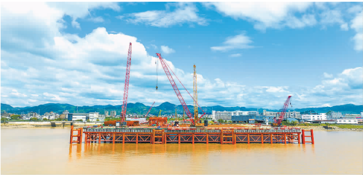
9月5日,浙江温州,新建温州至福州高速铁路瓯江公铁大桥北口航道桥32号主墩钢栈桥及钻孔平台全部搭设完成,为大桥水上主体工程建设奠定基础。 古建数摄(中经视觉)
