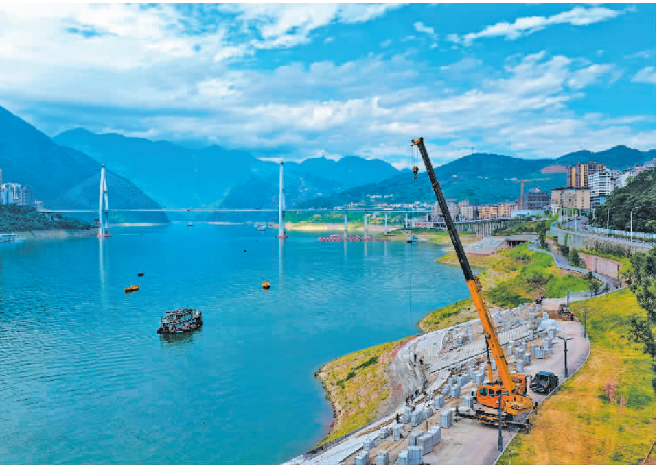
近日,工人在湖北省巴东县东溪溪下游至巴东长江大桥北岸段库岸安全防护工程建设现场施工。项目建成后,将进一步提升长江北岸库岸防洪抗灾能力。 焦国斌摄(中经视觉)
