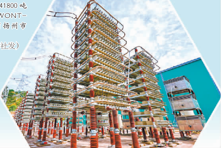
右图“疆电入渝”工程±800千伏渝北换流站交流滤波器场设备。
