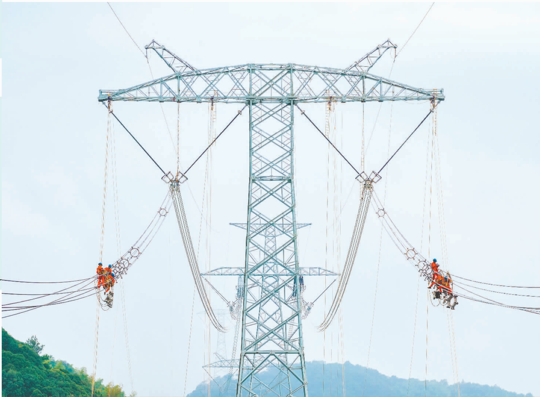
◀7月17日,上海市崇明区庙镇启瀛路,国网上海市电力公司带电作业人员冒着高温酷暑进行线路故障修复。 王宇庆摄(中经视觉)
