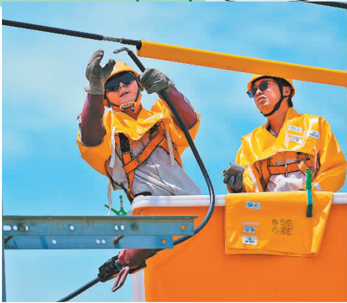
◀7月17日,上海市崇明区庙镇启瀛路,国网上海市电力公司带电作业人员冒着高温酷暑进行线路故障修复。 王宇庆摄(中经视觉)
