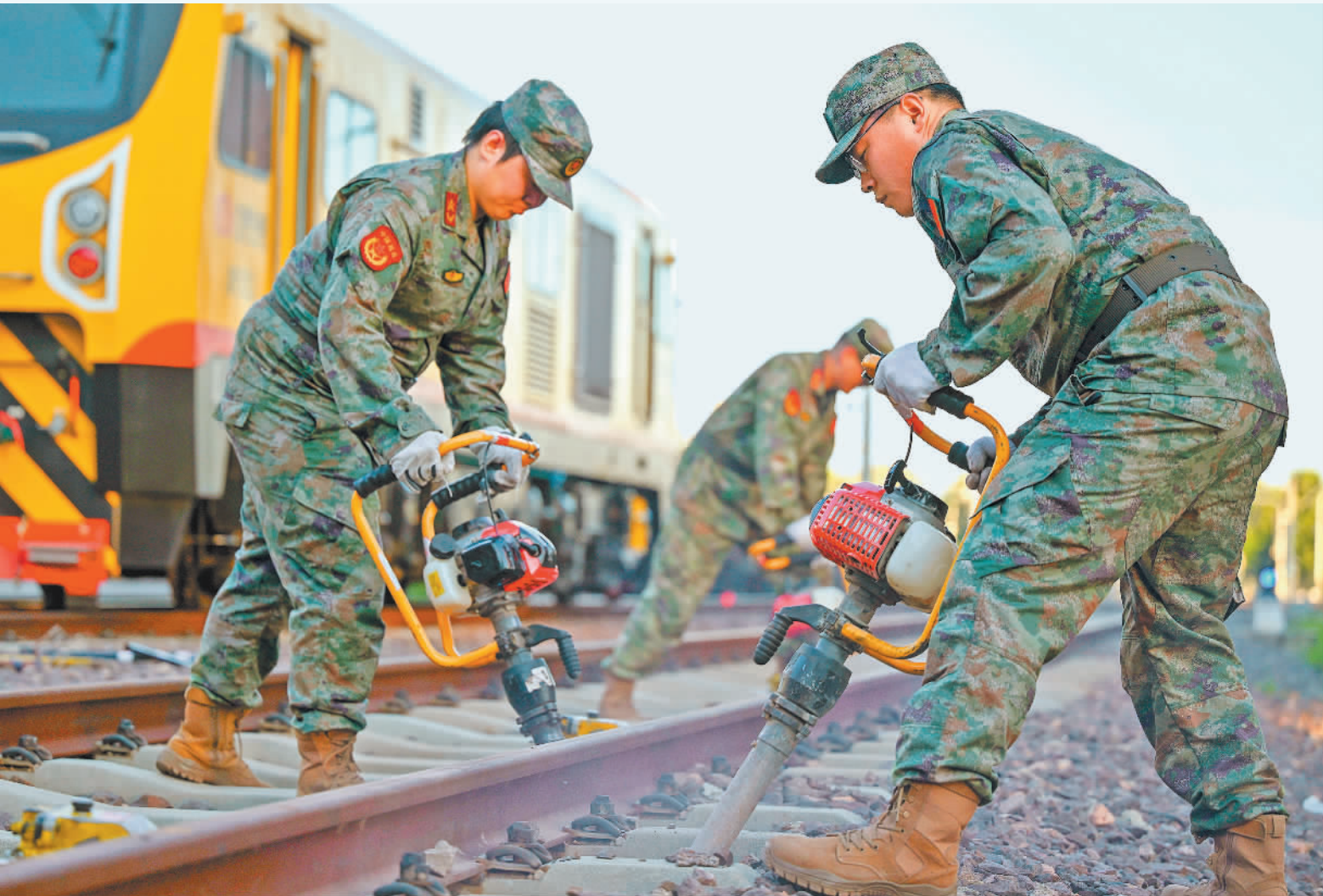
▼8月3日,安徽省合肥市轨道交通1号线珠江路车辆段,轨道救援分队民兵在进行线路捣固作业。 徐伟摄(中经视觉)
