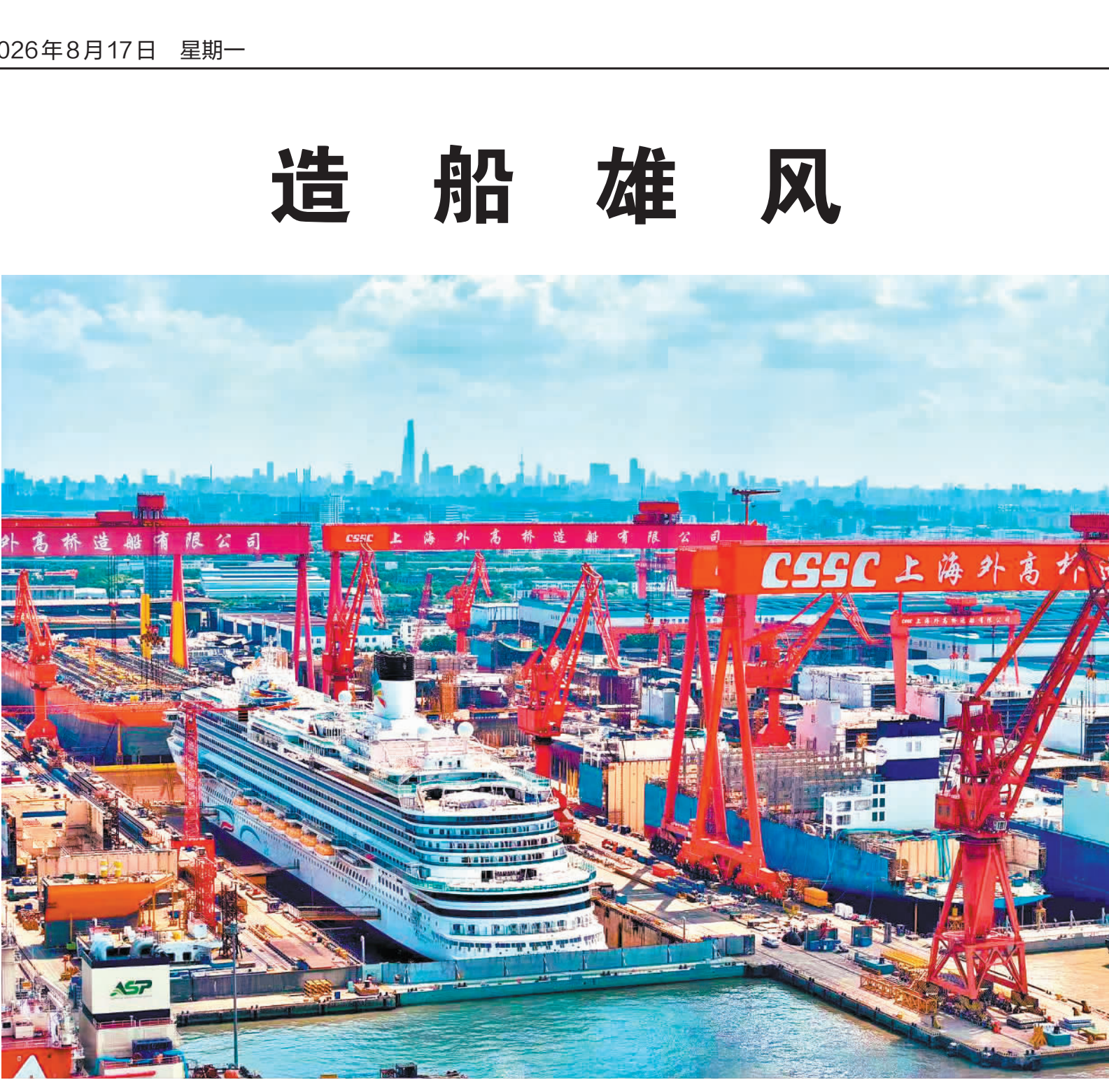
第二艘国产大型邮轮正在建造中。
