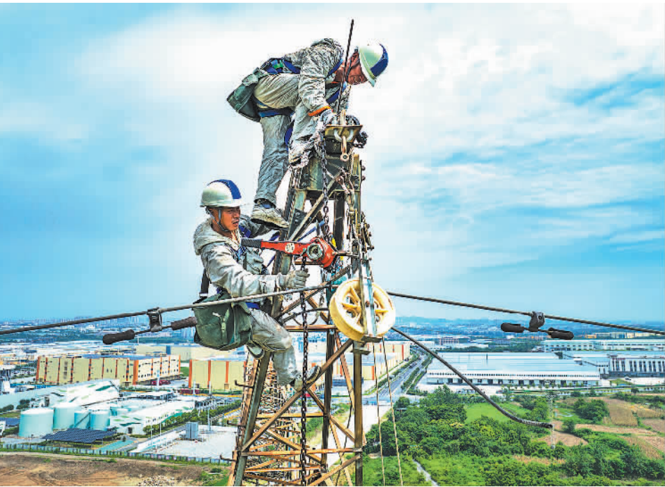
近日,在湖北省荆门市掇刀区,国网湖北超高压公司工作人员对500千伏龙斗二回相关设备进行紧急抢修,确保华中电网核心骨干通道安全。陈 军摄(中经视觉)
