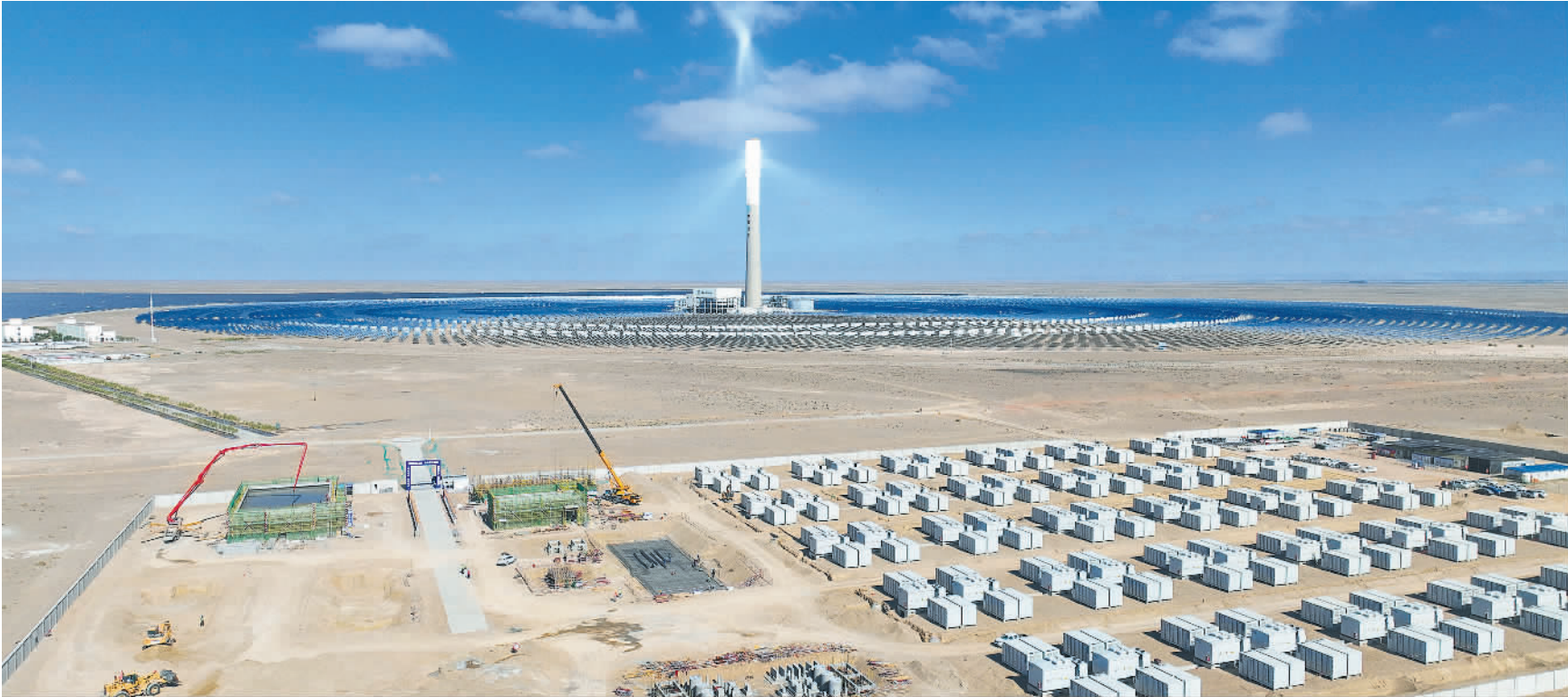
8月11日,在甘肃省酒泉市金塔白泉水300MW/1200MWh电网侧独立储能电站项目工地上,建设人员正加紧施工作业。近年来,金塔县聚焦新能源产业发展布局,全面激活清洁能源发展新动能,为县域经济绿色低碳转型、高质量发展筑牢坚实的能源保障体系。 曹红祖摄(中经视觉)
