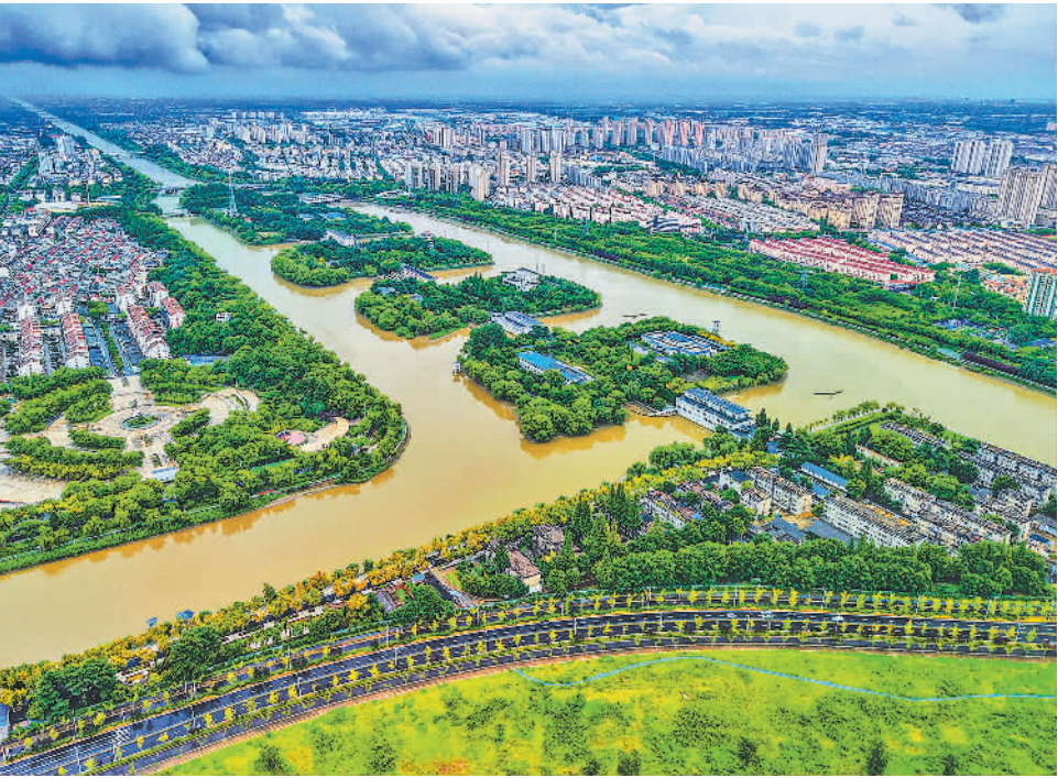
截至8月10日，南水北调东中线一期工程调水超900亿立方米。其中中线一期工程调水超800.5亿立方米，东线一期工程调水超99.5亿立方米。图为江苏省扬州市江都区的南水北调东线源头江都水利枢纽（无人机照片）。任飞摄（中经视觉）
