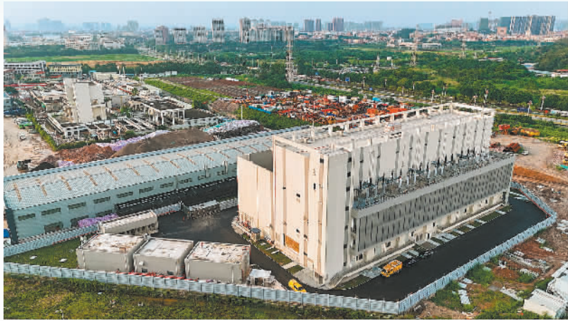
220千伏茶山（石步）输变电工程竣工投产
