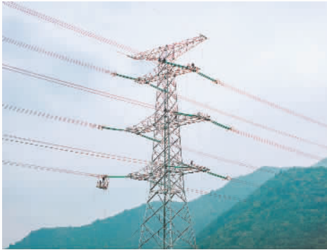
500千伏嘉岐甲乙线与嘉敬甲乙线交叉跨越改造完成
