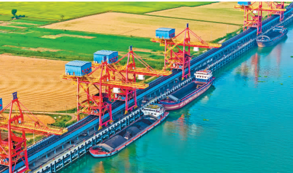
江西省宜春港丰城港区尚庄货运码头,桥吊起重机在装卸煤炭,并通过履带传输带运往火力发电厂发电,确保迎峰度夏。 周 亮摄(中经视觉)
