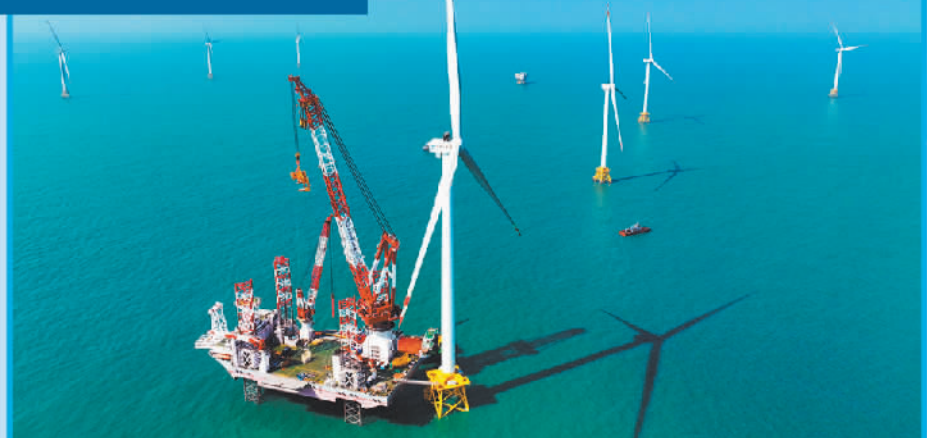
福建海域的20兆瓦海上风电机组和“大桥海风”号2000吨自升式海上风电安装平台。 新华社记者 林善传摄
