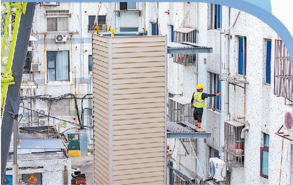
江苏省南通市通州区金沙街道虹南社区虹桥南村,工人正在进行老旧小区加装电梯吊篮施工作业。
