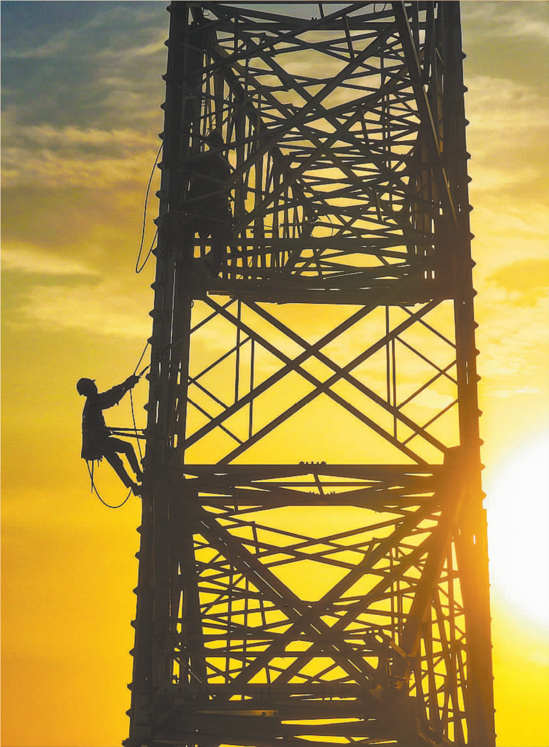
▲7月6日,电网工人在宁夏回族自治区银川市灵武市一处戈壁滩上开展输电铁塔组立作业。 袁宏彦摄(中经视觉) ►7月22日,浙江省温州市洞头状元岙港区,工人开展边坡加固施工作业,筑牢港区地质安全防线。 刘吉利摄(中经视觉)
