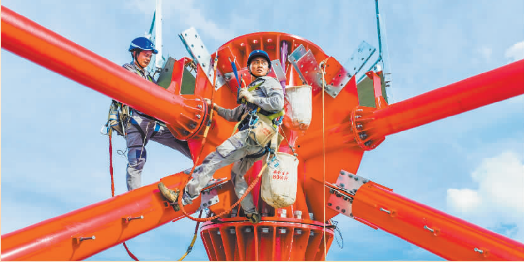
▼7月16日,安徽省无为市高沟镇,安徽送变电工程有限公司工作人员在高空组立特高压长江大跨越输电塔。建设者们执行错峰作业,避开正午高温时段,配备防暑降温物资,在保障安全的前提下,稳步推进西电东送重点工程建设。 郑贤列摄(中经视觉)
