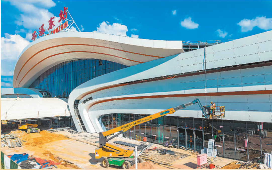
▲7月11日,位于广西壮族自治区岑溪市的岑溪东站建设现场,工人顶着高温进行施工作业。 颜金昌摄(中经视觉)
