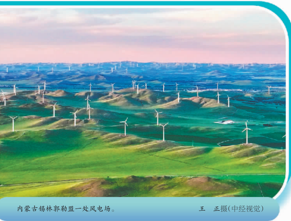
内蒙古锡林郭勒盟一处风电场。
