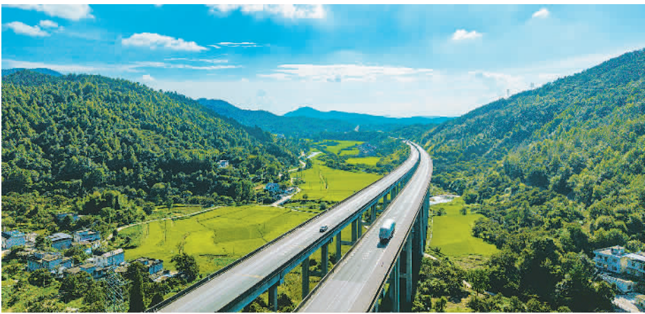
7月31日拍摄的湖北省黄冈市罗田县沪武高速公路凤凰关水库路段。近年来,当地加大交通基础设施建设,有效改善了群众出行和物流运输条件。王江摄(中经视觉)
