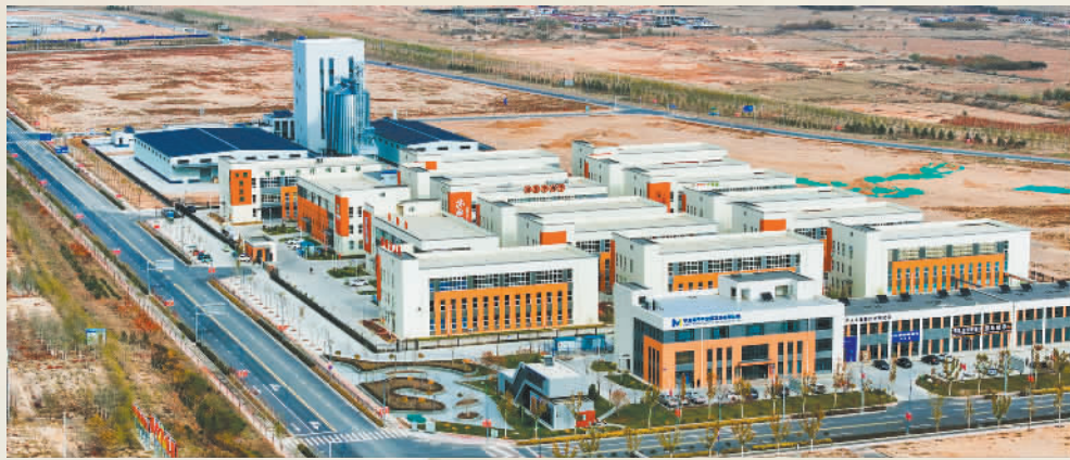
▲6月18日拍摄的闽宁产业园。产业园由福建厦门市湖里区、思明区与宁夏银川市永宁县三方共建,吸引了福建大数据集团、鸿星尔克等30多家企业入驻。 海 坤摄(中经视觉)
