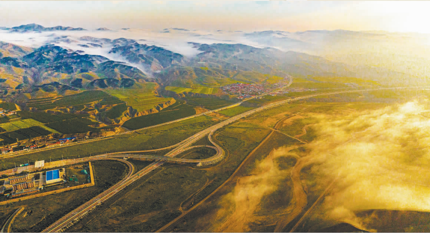
▼2025年8月拍摄的宁夏中卫市海原县高速公路。完善畅通的交通基础设施,有效打通了福建与宁夏之间的流动通道,为区域协调发展提供了坚强支撑。 李海龙摄(中经视觉)
