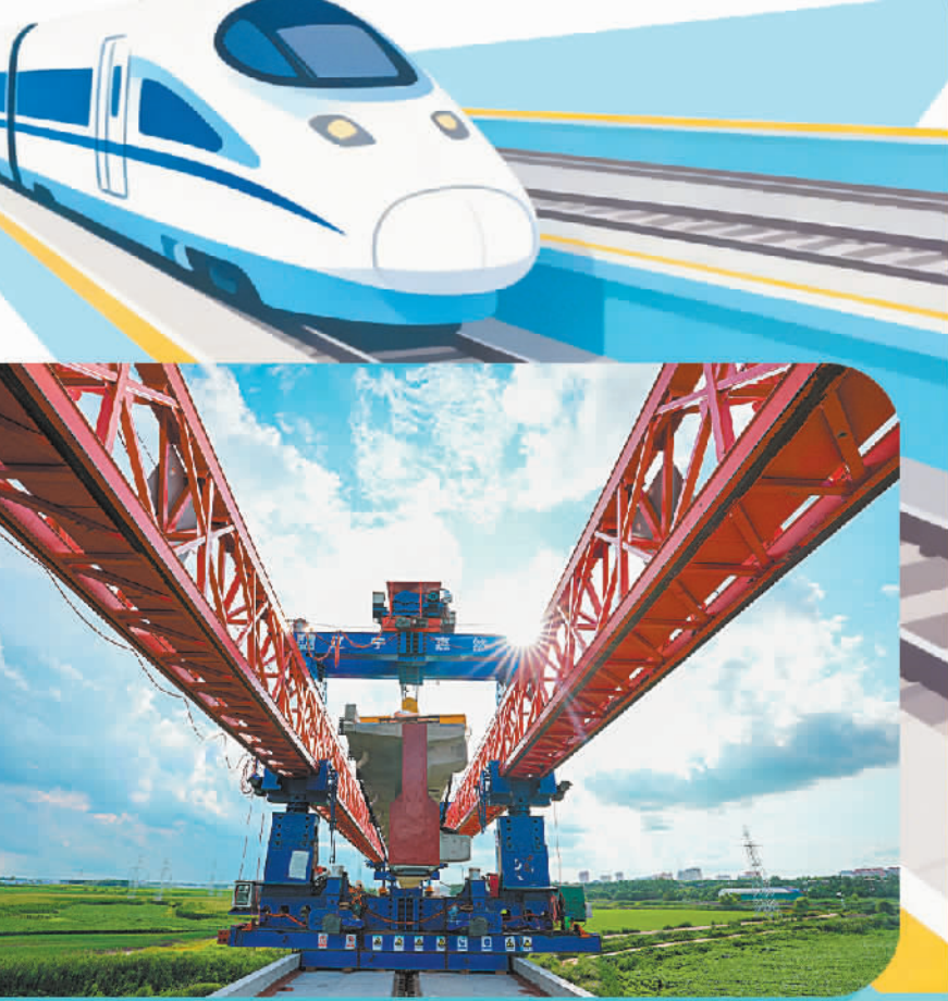
图为佳木斯至同江铁路扩能改造工程同江特大桥架梁施工现场。 新华社记者 王 松摄
