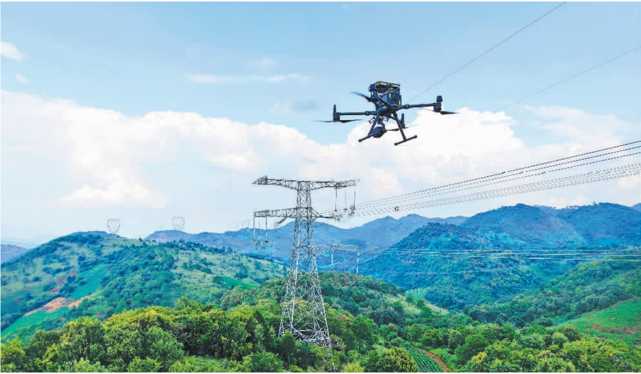
近日，南方电网云南电网公司在云南红河州建水县完成国内首次无人机与卫星直连输电线路巡检，成功破解无4G和5G信号、无地面差分定位的“双无信号区域”无人机自动巡检难题。该技术的突破，让云南近4800公里深山峡谷无信号区的输电线路，摆脱了以往“人工背设备进山、无人机手动盲飞”的巡检模式。 子晓东摄（中经视觉）
