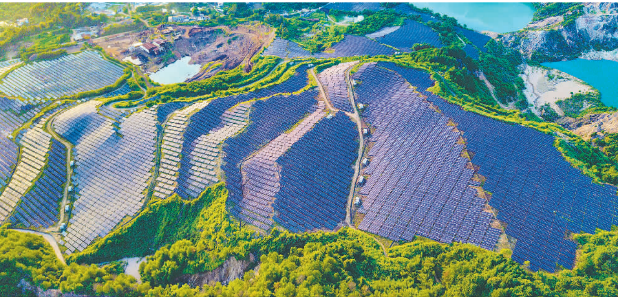
7月23日,位于广东省梅州市平远县原尖山废弃铁矿区,一排排光伏发电板依山铺展。近年来,当地积极践行“两山”理念,紧扣“双碳”目标,有序发展清洁能源。冯锡权摄(中经视觉)
