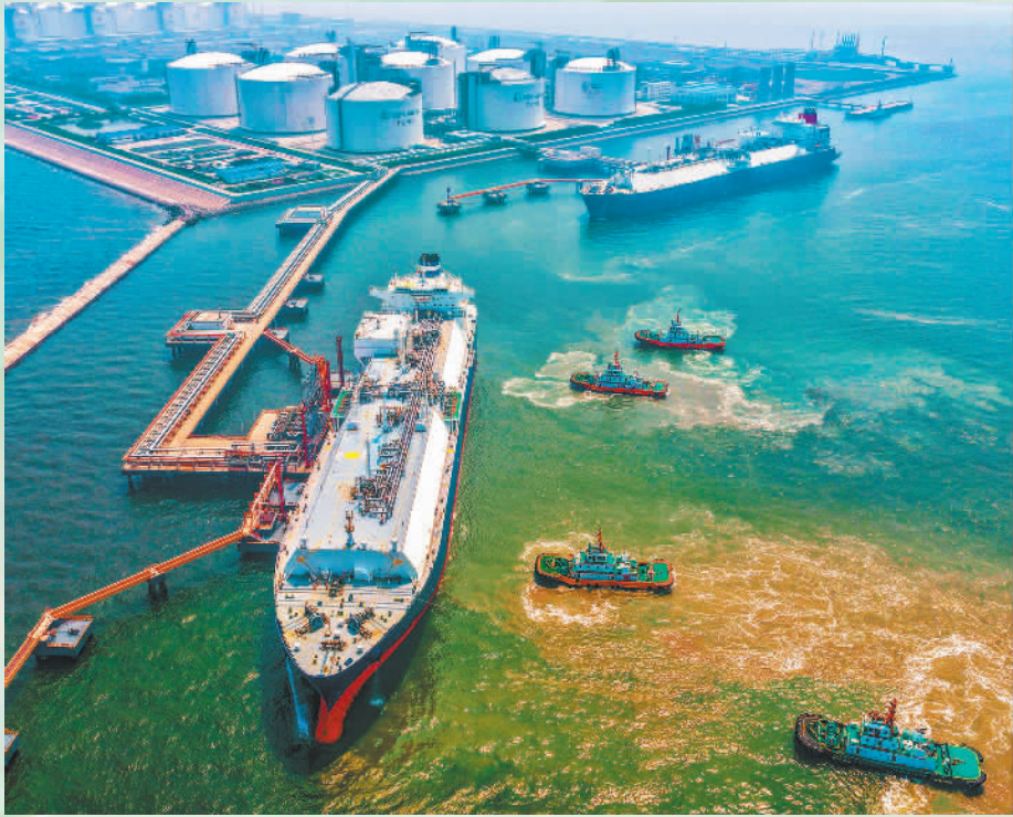
▲7月2日,在中国石化天然气分公司天津LNG接收站,两艘LNG运输船停靠码头,开始卸载液化天然气。 王 军摄(中经视觉)
