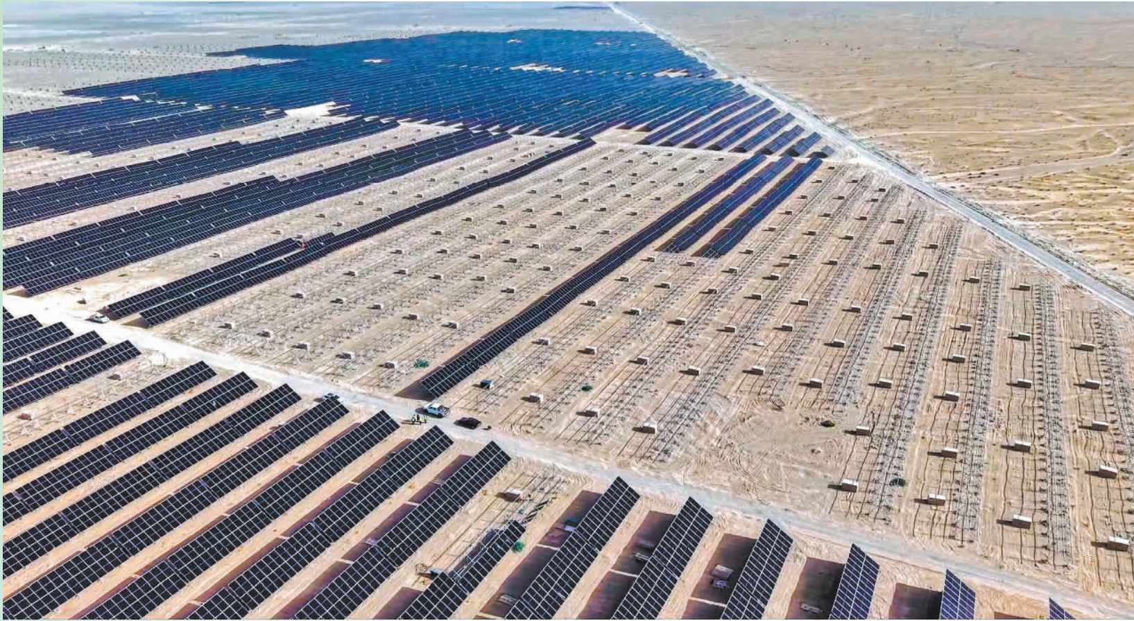
▲6月26日拍摄的位于和田地区的新疆民丰100万千瓦光伏治沙项目。该项目使用“板上发电、板下固沙、板间种草”立体生态治理模式,实现生态治理与绿色能源协同发展。
