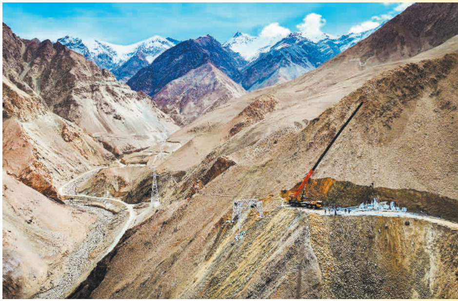
▲6月29日,由新疆送变电有限公司承建和田220千伏输变电工程全速攻坚。该工程是补齐和田南部山区电网短板的关键工程,投运后将保障新增负荷供电,支撑经济高速发展。
