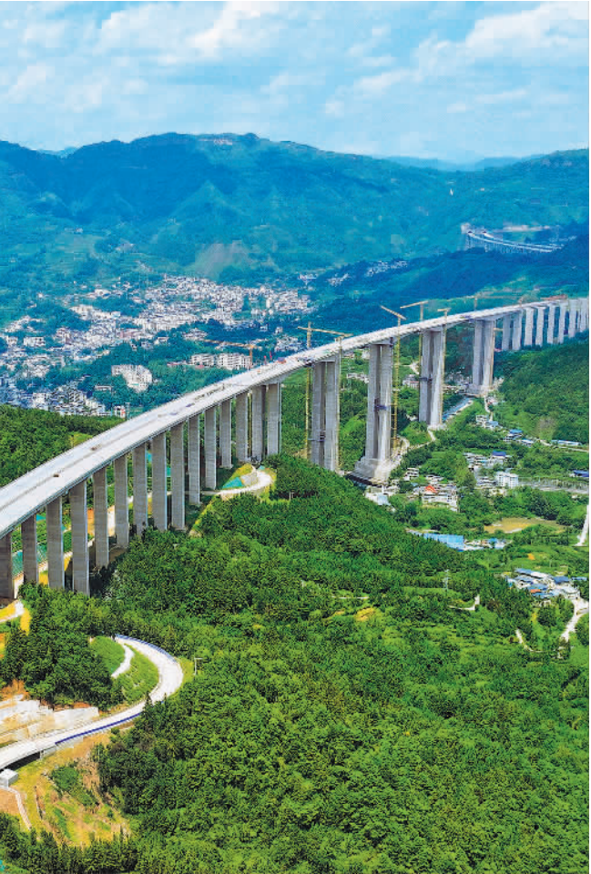
7月16日，位于贵州省盘州市盘关镇的安（顺）盘（州）高速控制性工程——盘关特大桥主桥顺利合龙，为高速公路全线如期建成通车奠定了基础。本报记者 吴秉泽摄
