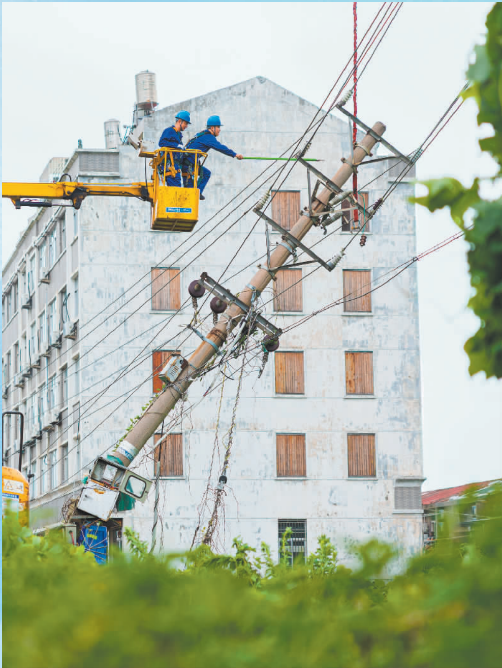
▲7月12日,浙江省温岭市松门镇松寨村,供电公司员工紧急抢修被台风“巴威”损毁的断裂电杆。 徐伟杰摄(中经视觉)
