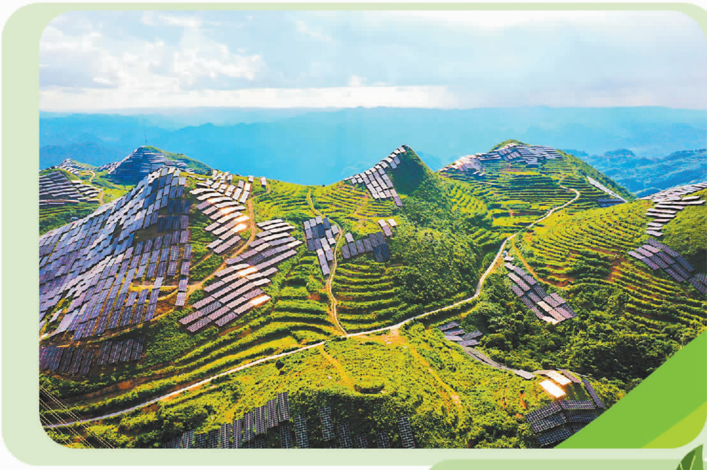
位于贵州省福泉市道坪镇的仙桥厂区农光互补光伏项目。易盛武摄(中经视觉)
