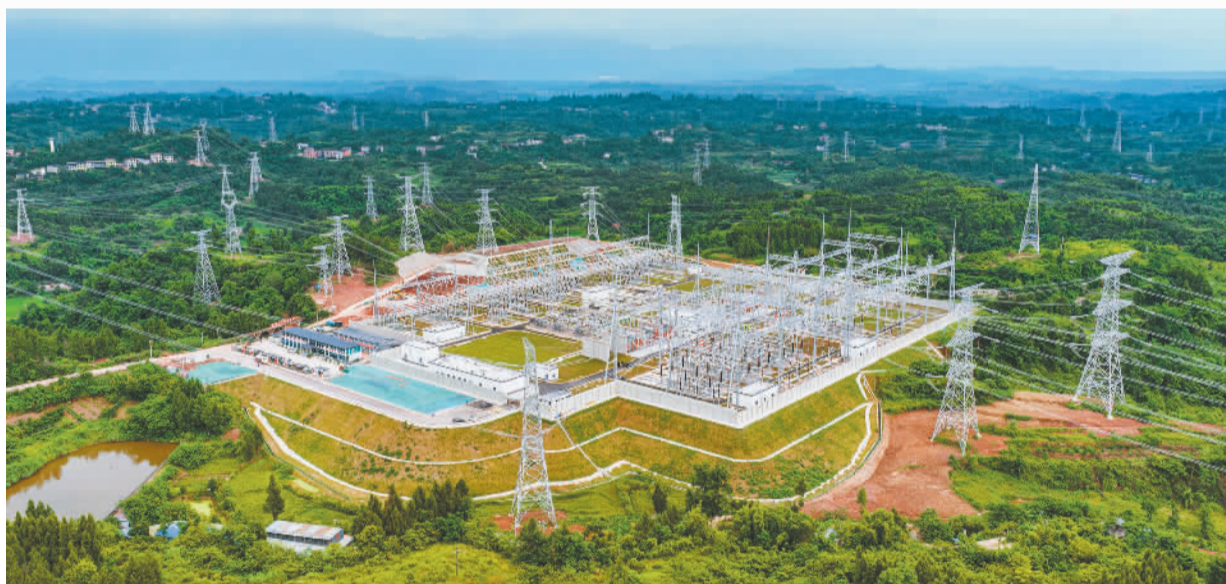
俯瞰位于四川广安石笋镇芭蕉湾社区的四川广安 II 500 千伏变电站。该工程大幅提升区域电网承载能力与运行稳定性，保障民生及工商业用电需求。张波摄（中经视觉）
