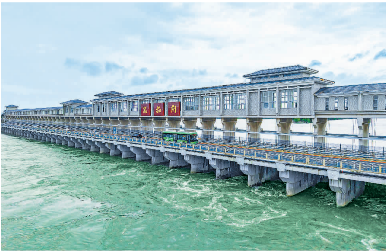
近日，江淮地区连续降雨导致水位上涨。根据江苏省水旱灾害防御调度中心指令，江都水利枢纽万福闸于7月4日9时30分向廖家沟开闸放水流入长江。这是7月5日拍摄的万福闸开闸放水。
