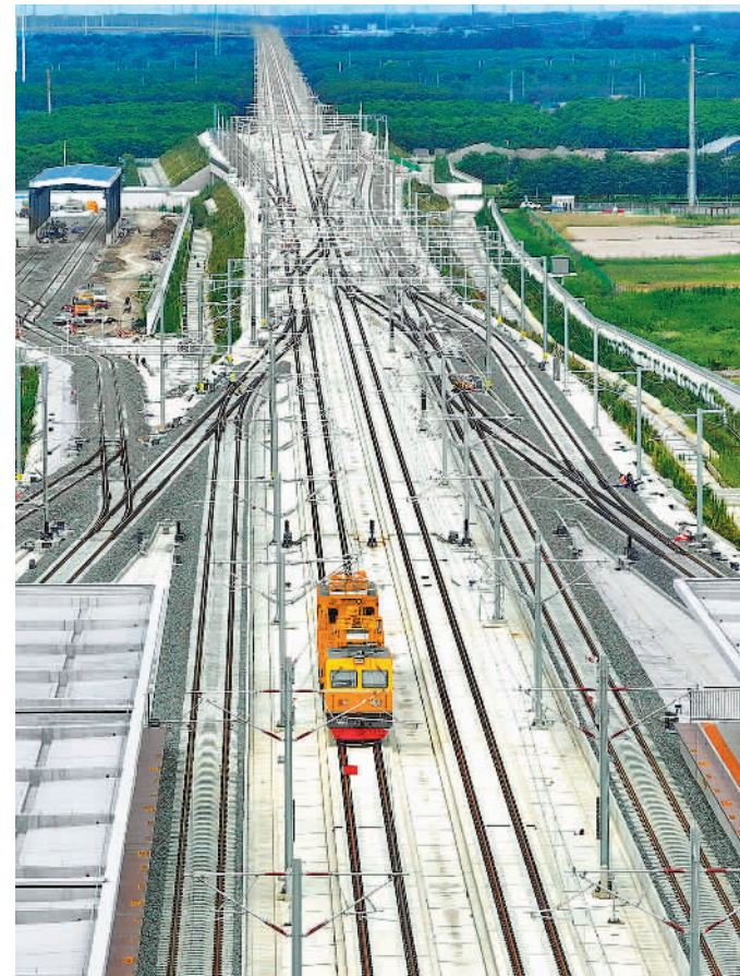
7月5日，安徽省亳州市境内淮阜高铁建设现场，工人正在加紧施工。近日，淮阜高铁正式启动静态验收工作，标志着该高铁主体工程建设基本完成。胡卫国摄(中经视觉)
