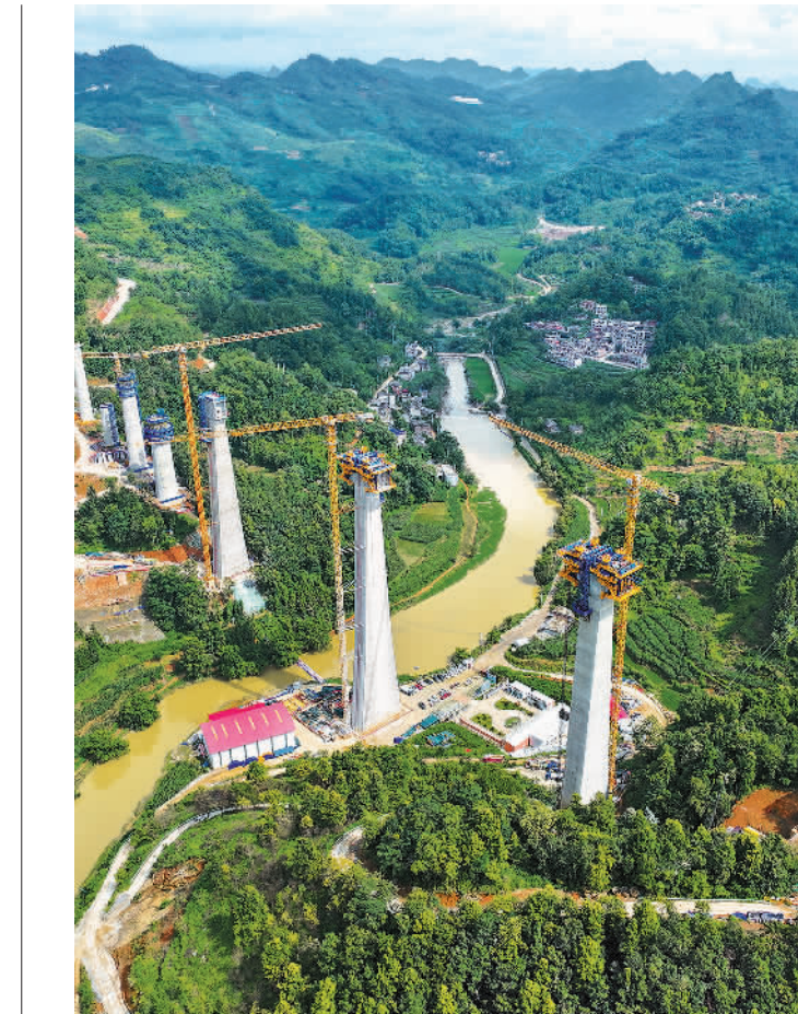
7月2日，位于贵州省安顺市镇宁县本寨镇的黄百铁路六志河特大桥开始悬臂梁施工。黄百铁路建成后，将进一步完善西部陆海新通道布局。龙建春摄(新华社发)
