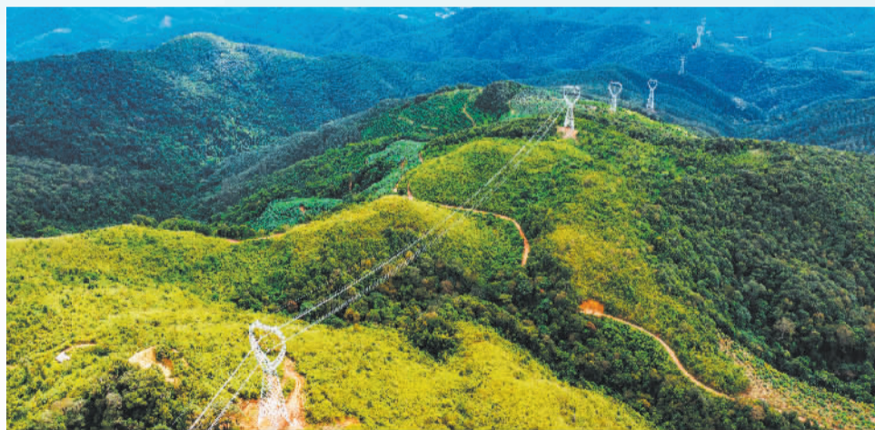
2026年4月20日，我国率先落地500千伏跨境交流联网工程——中老500千伏联网工程正式投产，该工程亦是中老两国合作建设、规模与电压等级均处于领先水平的跨境电网工程。
