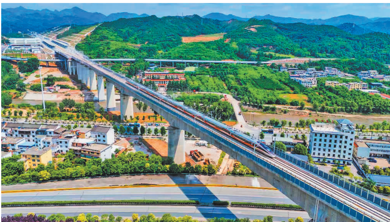
6月30日，西十高铁列车行驶在南秦河特大桥上。当日9时16分，G3966、G3969次列车分别从西安东站和十堰东站对向开出，西安至十堰高速铁路正式开通运营。 闫竹青摄(中经视觉)
