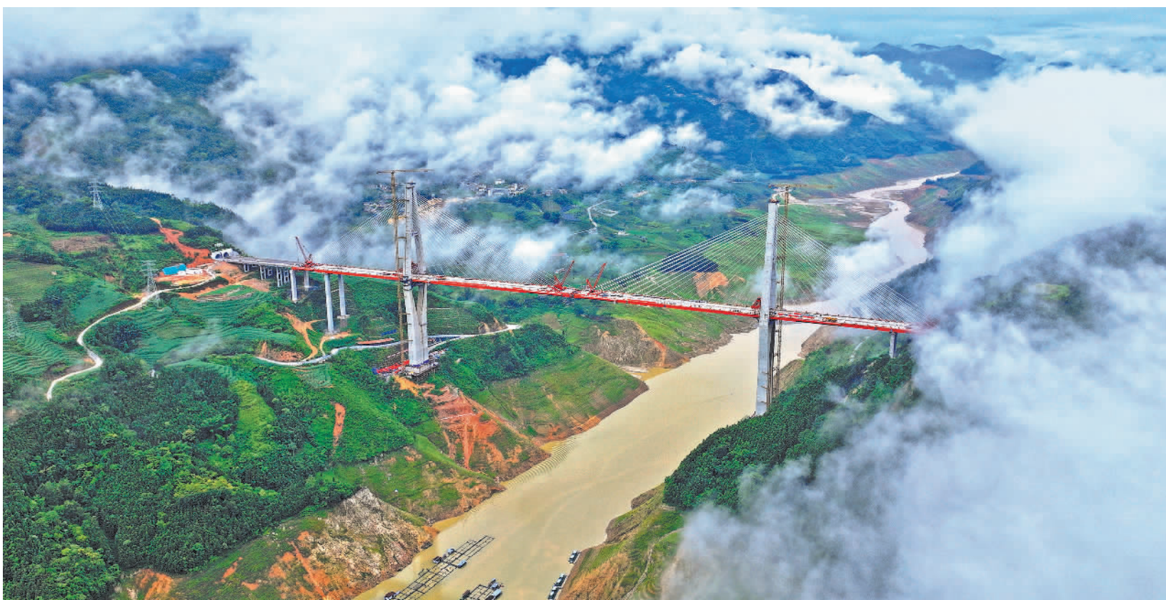
6月28日,位于云南省文山壮族苗族自治州的天麻高速马鹿塘特大桥合龙,天麻高速实现全线贯通。天麻高速全长52.8公里,通车后将完善滇东南边境高速公路网,助力特色农业、文旅资源开发。
