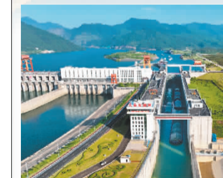
大藤峡水利枢纽工程船闸24小时通航，每日过闸16至18闸次
