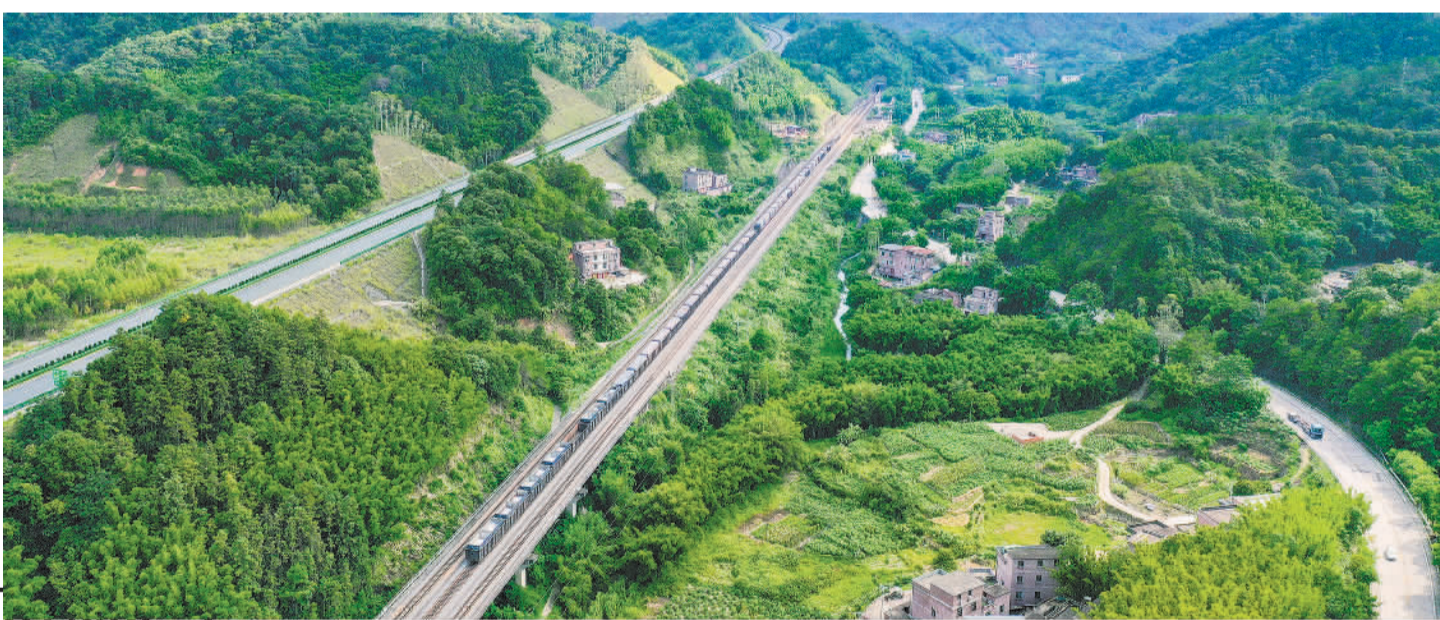
6月23日,广西梧州市苍梧县旺甫镇山心村,高速公路、铁路、国道在翠绿的群山中蜿蜒。近年来,当地加强交通基础设施建设,织密由高速公路、铁路、国道、县道、乡村公路组成的立体交通网。黎杰源摄(中经视觉)
