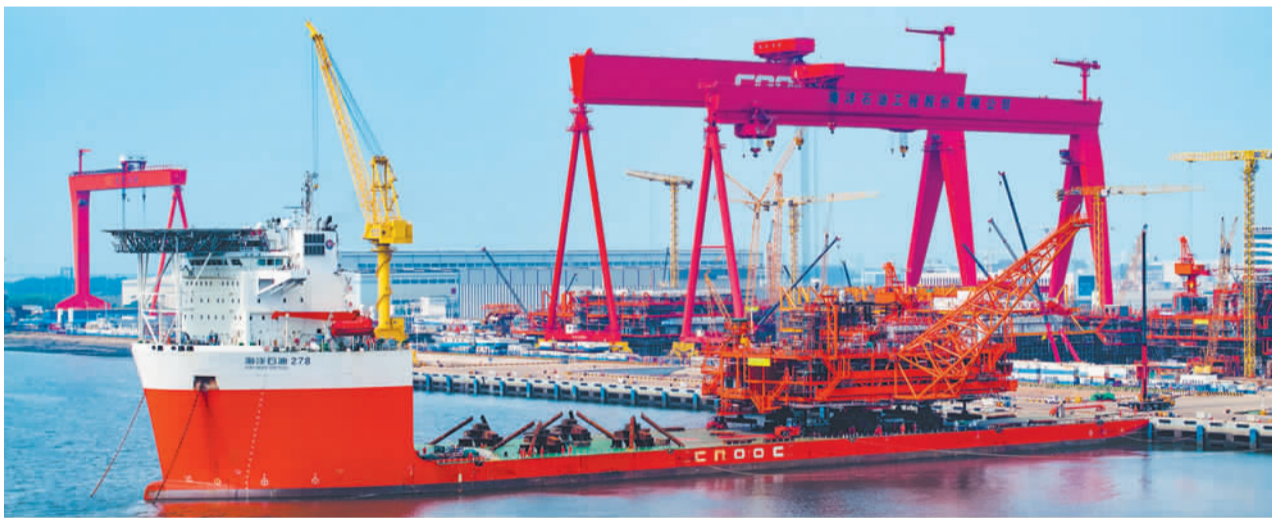
6月16日，随着最后一座平台在天津市滨海新区成功装船，全球最大变质岩油田——渤中26—6油田开发项目（二期）全部平台陆地建造完工，为油田按期投产奠定基础。
