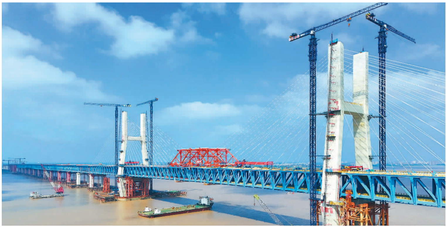
6月9日,由长江沿岸铁路集团江苏公司建设、上海国铁建管公司管理、中铁大桥局施工的世界最大跨度公铁两用无砟轨道斜拉桥——崇启公铁长江大桥主桥成功合龙。该大桥通车后,上海至启东铁路通行时间将显著缩短,对完善长江经济带综合立体交通走廊、服务长三角一体化高质量发展等具有重大意义。 欧阳耀中摄(中经视觉)
