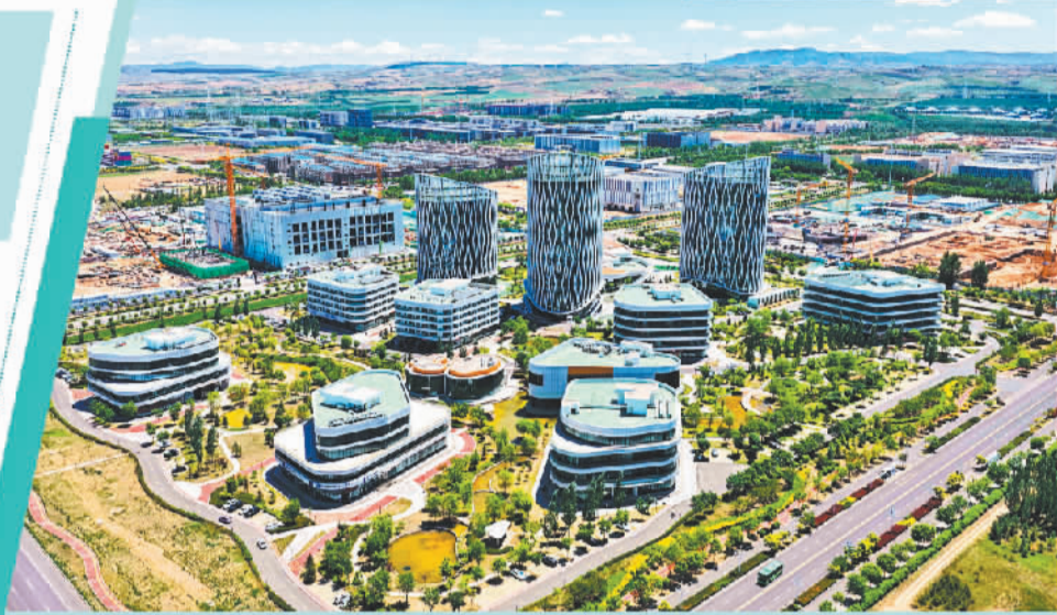
6月4日在内蒙古呼和浩特和林格尔新区拍摄的人才创新谷。目前,人才创新谷已有50余家算力相关企业入驻。近年来,呼和浩特持续推进绿色电力与算力协同布局,加快内蒙古枢纽节点和林格尔数据中心集群建设。新华社记者 李志鹏摄
